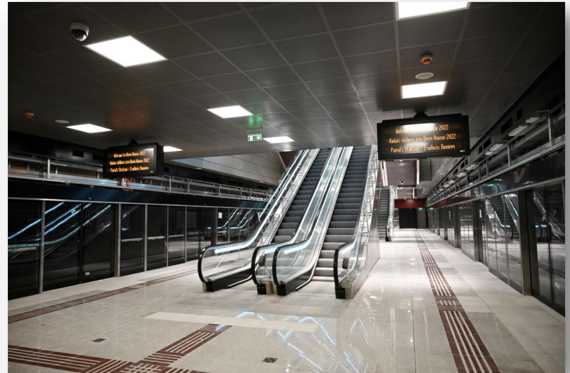
Σταθμός Παπάφη Επίπεδο αποβάθρας
